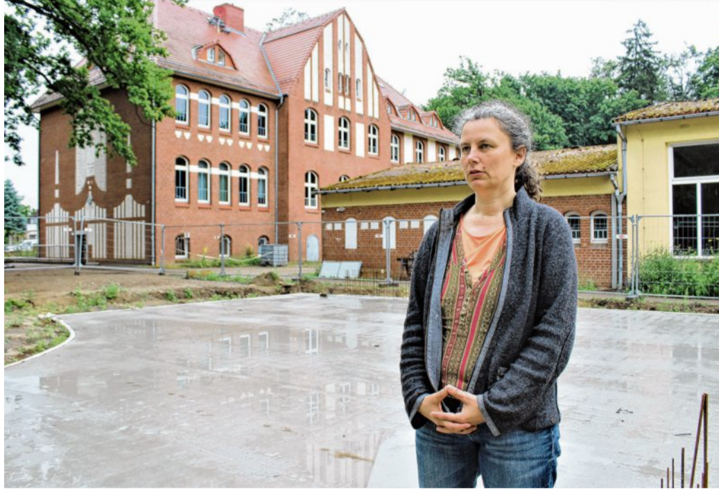
Der Fortgang der Bauarbeiten für die neue Grundschule auf dem Gelände der Aktiven Naturschule Templin ist noch nicht in Sicht. Gestiegene Preise für Baumaterial haben Probleme geschaffen, informierte Standortkoordinatorin Juliane Seidel.
